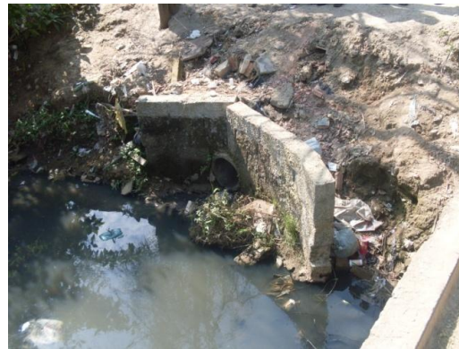
Figura 13: Construção feita pela prefeitura.
