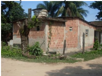
Figura 10: Residência sem reboco e rua sem calçamento.
