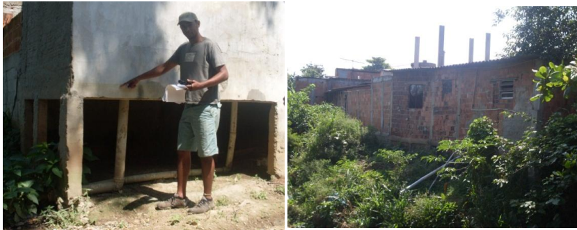
Figura 14: Ligações de esgoto diretas no rio.
