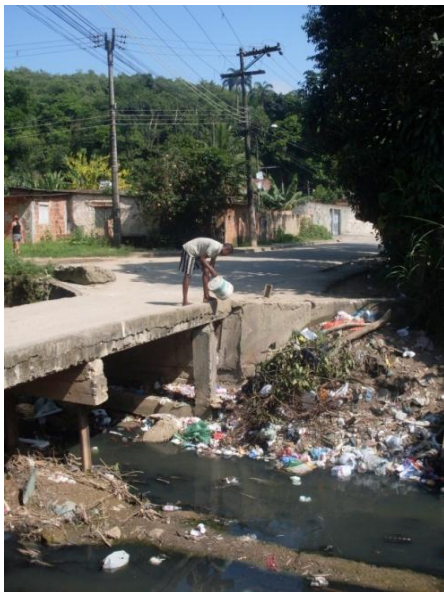
Figura 12: Ponte construída pelos moradores.
