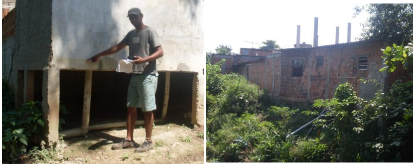
Figura 14: Ligações de esgoto diretas no rio.
