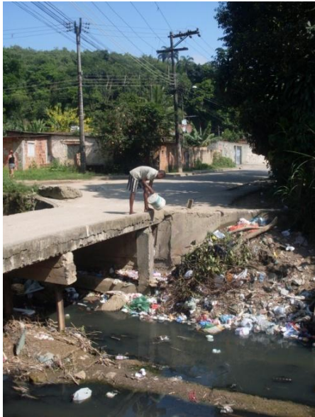
Figura 12: Ponte construída pelos moradores.
