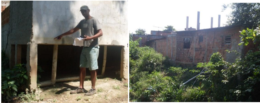
Figura 14: Ligações de esgoto diretas no rio.
