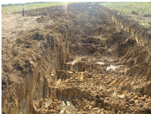
Figura 3: Vista de uma área já explorada onde não foi depositado o horizonte A do solo (Foto: do autor).
