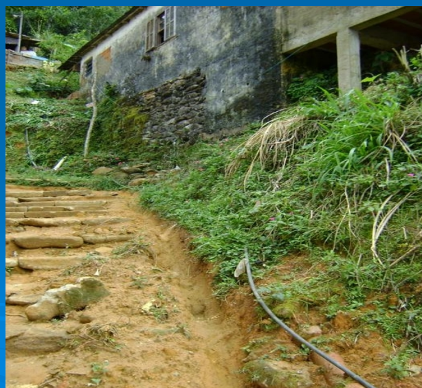
Pequena canaleta feita pelos moradores para escoar a água que desce a encosta em dias de pluviosidade intensa. F. S. Lima.
