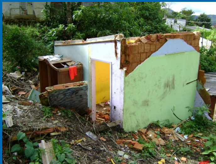
Detalhe da casa atingida pelo deslizamento de terra. Casa construída sob depósito de talus. Foto F.S. Lima.
